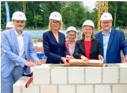
Legten bei der Grundsteinlegung für den Erweiterungsbau der Oberschule im Park die Zeitkapsel ins Mauerwerk (von links): Alexander Hamacher (Hegemann-Reiners-Gruppe), Schulleiterin Monika Steinhauer, IB-Geschäftsführerin Uta Kummer, Bildungssenatorin Sascha Karolin Aulepp und Finanzsenator Björn Fecker.
