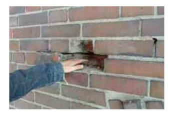
Foto 1 Teilöffnungen des Mauerwerks zeigen an, dass die denkmalgeschützte Fassade dringend saniert werden muss.
