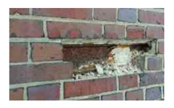
Foto 2 Deutlich zu erkennen: Korrodierte Eisenträger hinter den Ziegeln verursachen schwere Schäden.
