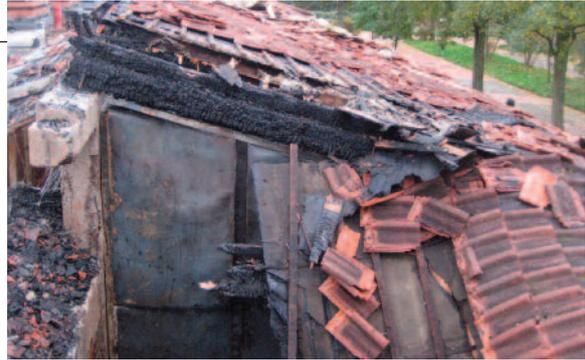
Waren es also doch Arbeiten am Dach, die kurz vor Ausbruch des Feuers nachlässig erledigt worden waren und einen Schwelbrand auslösten? Ein von der Versicherung zu Rate gezogener Brandexperte kam zu diesem Ergebnis. Nun muss ein Gericht entscheiden, ob die Haftpflichtversicherung des Dachdeckers den Schaden von rund 1,5 Millionen Euro trägt.
